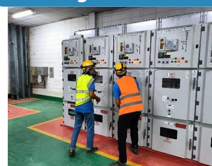
ตรวจสอบหน้างาน Lock Out Tag Out ซ่อม CR.3
