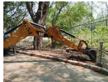
ขุดหลุมสำหรับวางเสาใหม่จำนวน 5 ต้น
